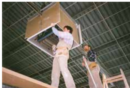
1994 Halle, Umbau Decke
